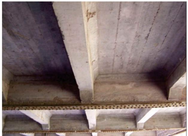
**Figura 15.** Detalle del tablero. Vista inferior donde se observa el casetonado.
