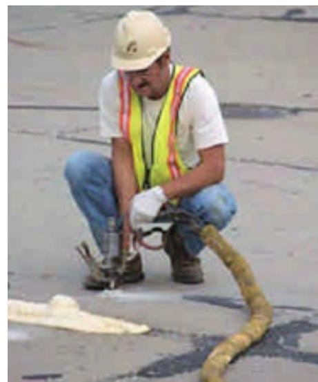
**Figura 5.** Refuerzo de fisura con pasadores (a) e inyección de losa con poliuretano expandido (b).
