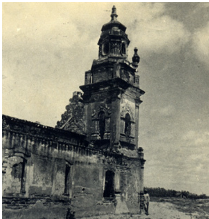
Figura 2. Lateral de la Iglesia de Almofala después de la retirada de la arena [Fuente: Archivos de la Superintendencia IPHAN - Fortaleza-CE].
