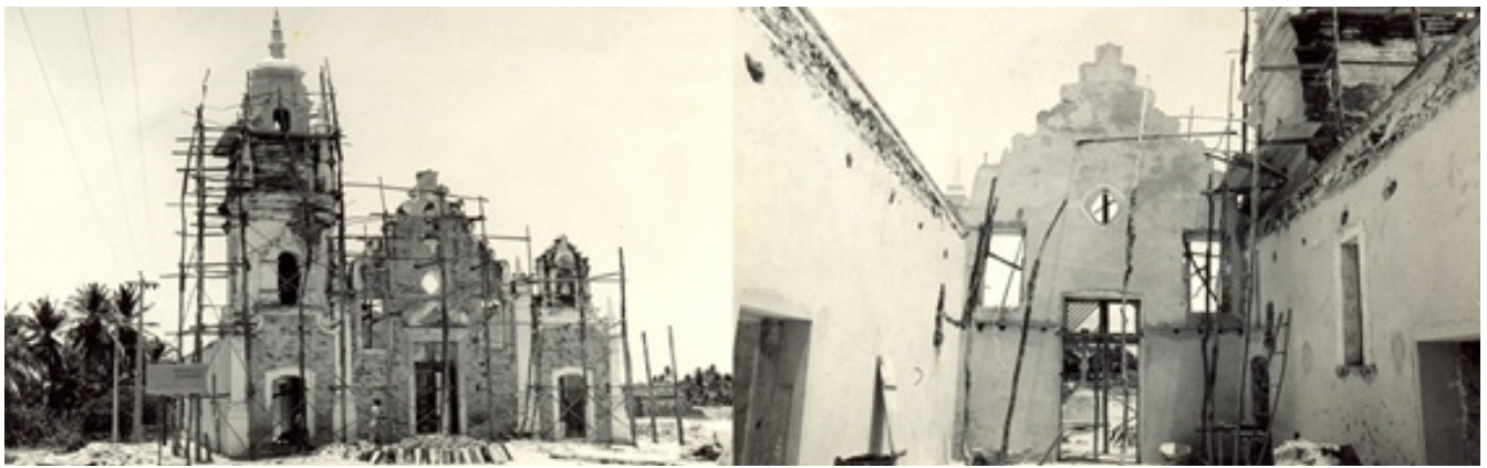
Figura 9. Rehabilitación de 1983. Andamio montado para recuperación de fachada (izquierda) y vista interior después de remoción del techo (derecha) [Fuente: Superintendencia IPHAN de Fortaleza - CE].
