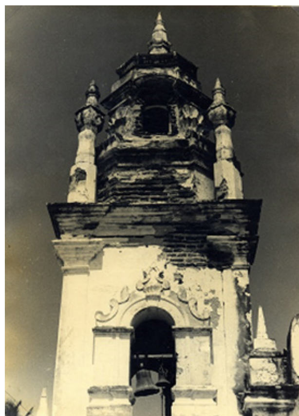
Figura 5. Torre de la iglesia aún sin reparar [Fuente: Superintendencia IPHAN de Fortaleza-CE].
