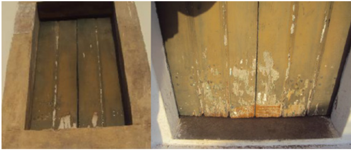
Figura 14. Madera gastada en puertas y ventanas exteriores.
