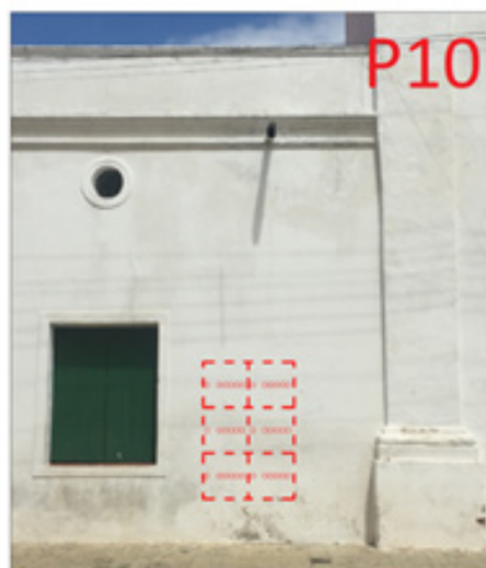
Figura 10. Mapeamento das velocidades ultrassônicas (m/s) do painel P10.
