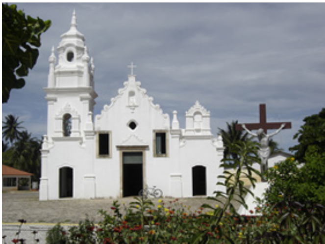
Figura 10. Iglesia de Almofala un año después de la rehabilitación de 2005 [Fuente: Superintendencia IPHAN de Fortaleza - CE].
