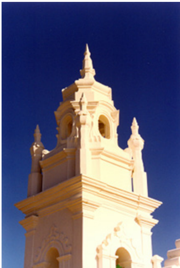
Figura 6. Torre de la Iglesia de Almofala después de la rehabilitación en 2005 [Fuente: Superintendencia IPHAN de Fortaleza - CE].
