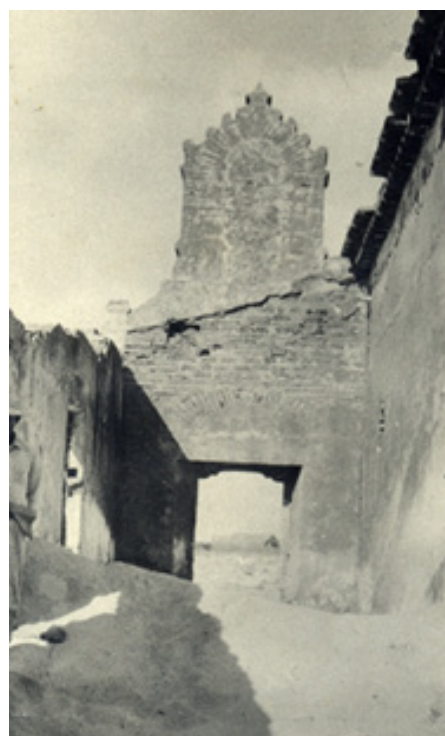
Figura 1. Vista interior de la Iglesia de Almofala después de retirada de la arena [Fuente: Superintendencia IPHAN de Fortaleza - CE].
