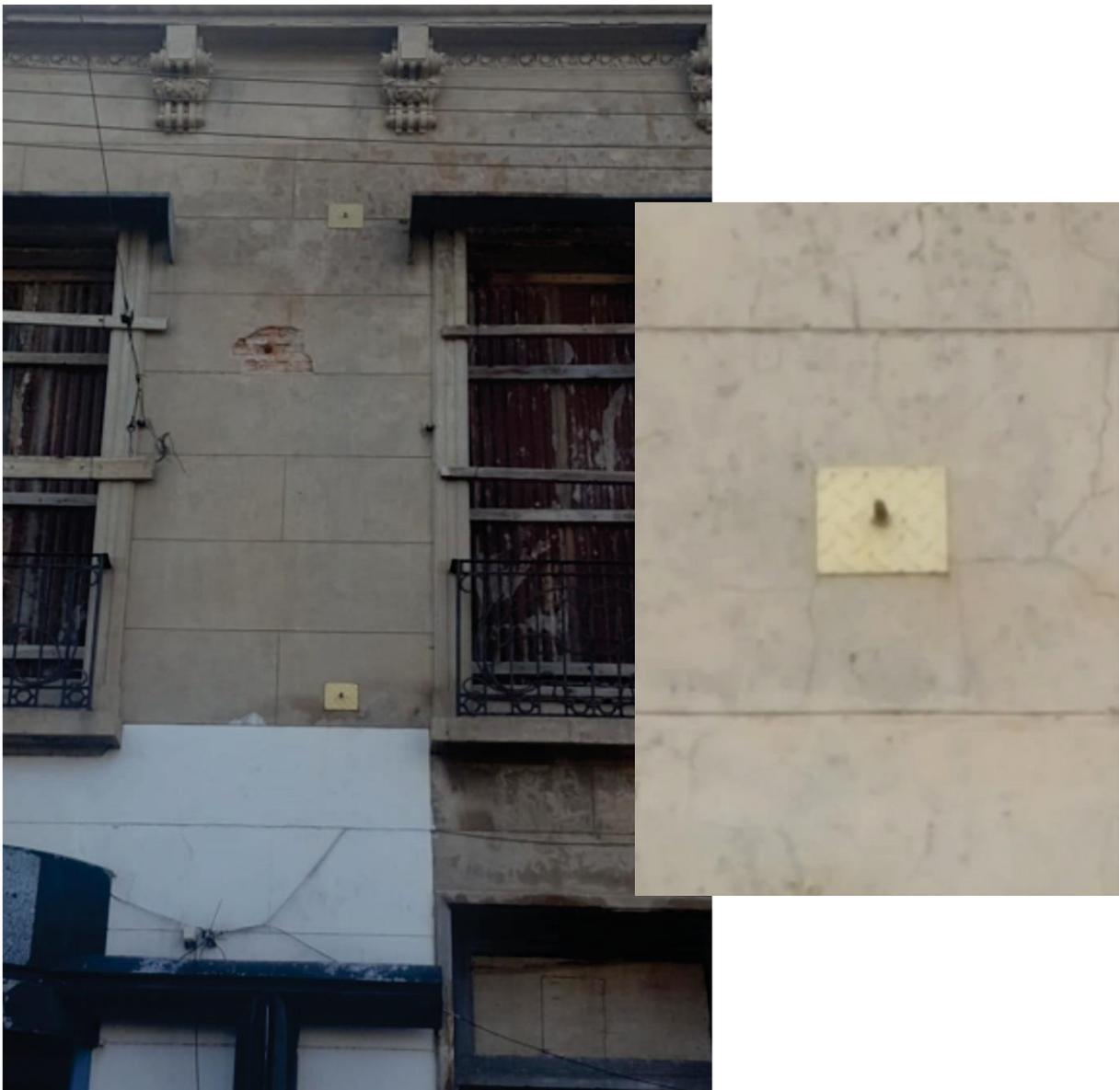
**Figure 8.** Vista externa de insertos dispuestos en columnas de hormigón.
