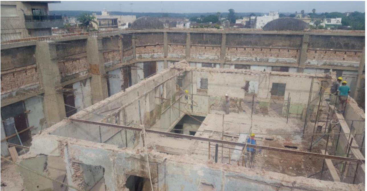
**Figure 10.** Vista superior demolición de mamposterías, luego del retiro de cubiertas y de la estructura de arriostamiento de las fachadas.
