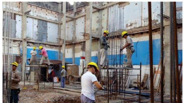
**Figure 5.** Estructura de hormigón armado para la conservación de fachadas.
