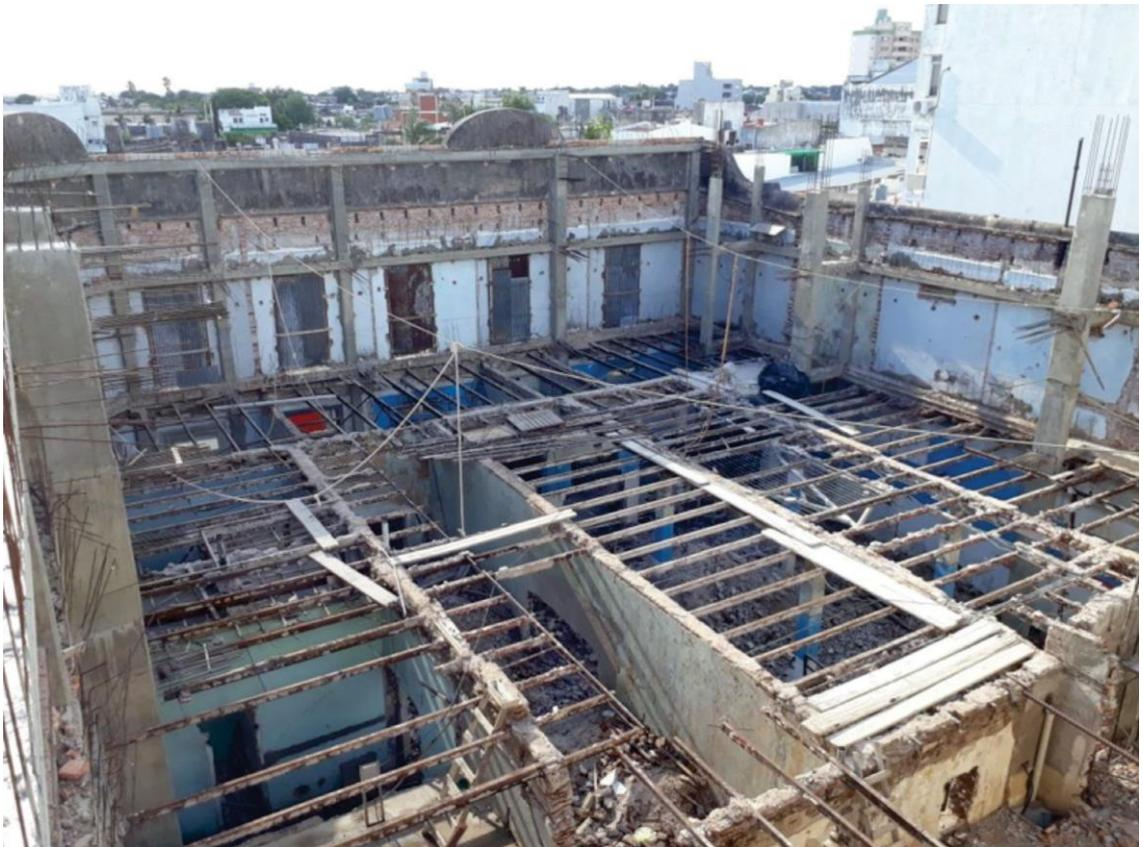
**Figure 12.** Vista superior demolición de plantas internas y estructuras de refuerzos de fachadas.
