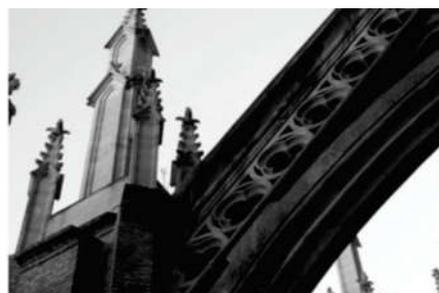
**Figura 7.** Vista de un arbotante. Se observa el manto biogénico.
