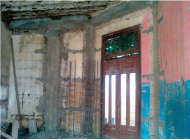
**Figura 2.** Refuerzo de Hormigon.
