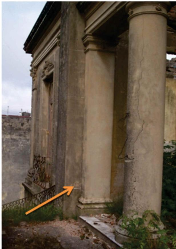
**Figura 8.** Importante grado de fisuración de elementos portantes, deprendimiento de ornamentaciones.
