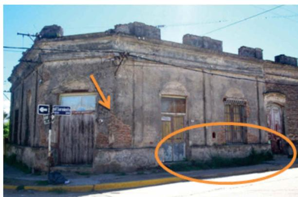
Figura 3. Ataque de microorganismos, crecimiento biológicos, desprendimiento de revocos.
