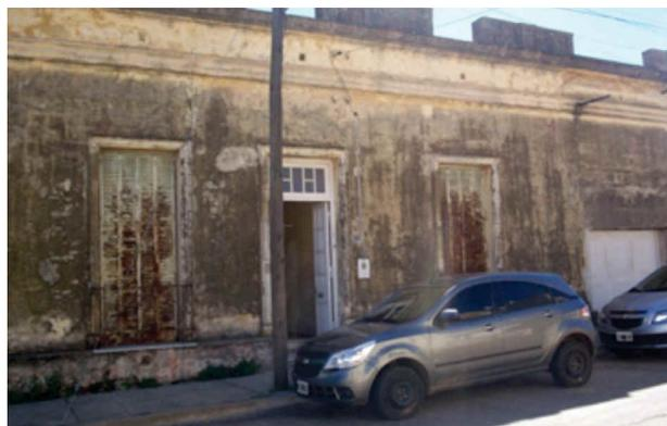
**Figura 6.** Corrosión de elementos metálicos, desmejoramiento de cerramientos.
