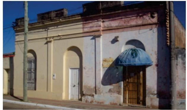
**Figura 7.** Formación de fisuras, desprendimientos de revoques.
